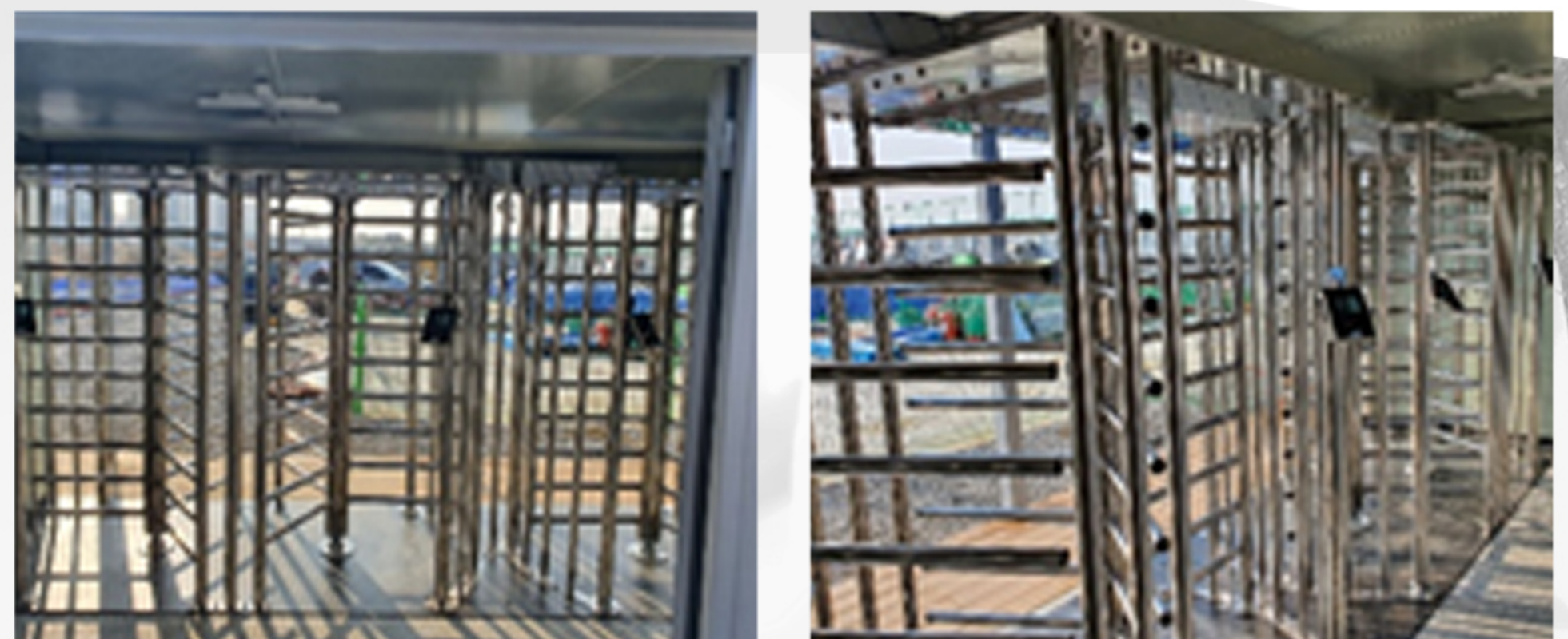
D 건설사 파주운정 현장
